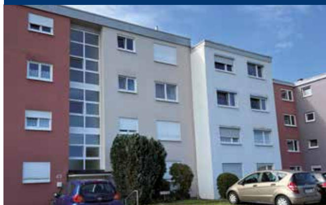
Sanierung ‚Am Buchs 45–47‘ in Künzelsau
