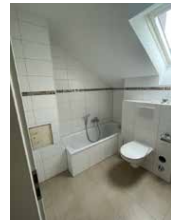
Badsanierung „Egelgraben 14“ in Niedernhall
