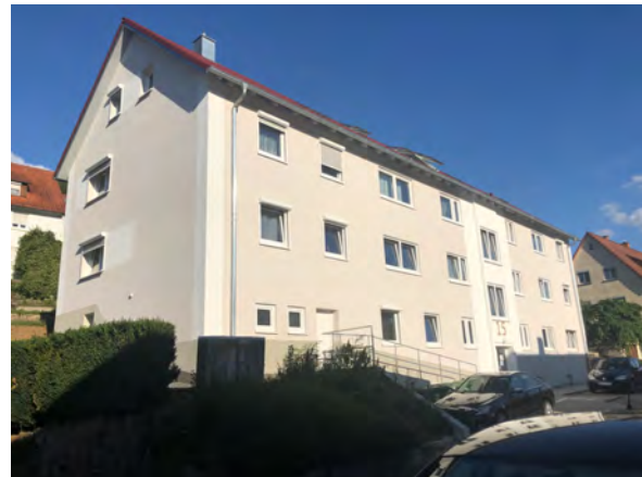
Künzelsau, Finkenweg 15 nach der Sanierung
