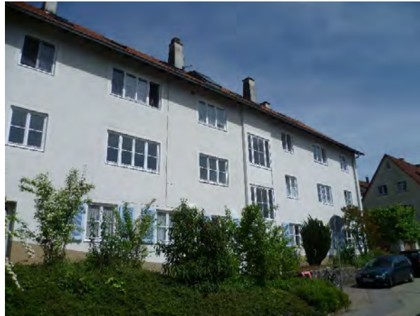
Künzelsau, Finkenweg 15 vor der Sanierung
