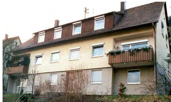
Niedernhall, Burgstallstraße 33 vor der Sanierung
