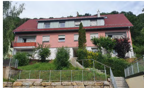
Niedernhall, Burgstallstraße 33 nach der Sanierung
